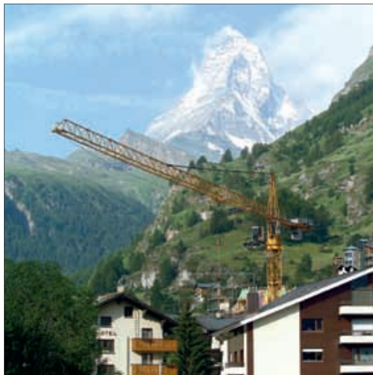
Hemmungslos wird unser Heimatboden überbaut.
